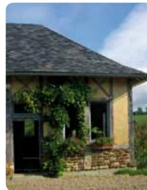
Le torchis est un mélange de limon argileux et de paille ou de foin, avec un enduit de chaux naturelle. Le bois utilisé est généralement du chêne, mais aussi de l'orme ou du hêtre et les pans de bois sont assez espacés. Le charme des constructions à pan de bois s'explique aussi par l'irrégularité des pièces de bois.
